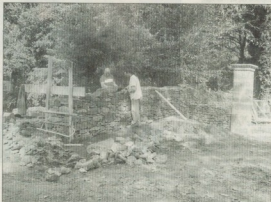
Arsatis applique des méthodes de travail ancestrales pour la réalisation de chantiers de maçonnerie traditionnelle et de pierre de taille...
