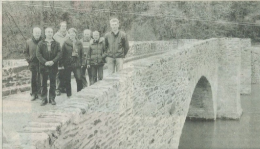
LIFTING. Le vieux pont de Solignac a été rénové. Les travaux ont été réalisés de mars à septembre sous la responsabilité de Limoges Métropole.
