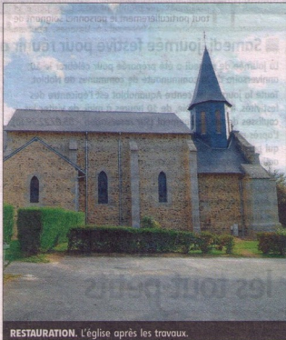
RESTAURATION. L'église après les travaux.
